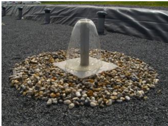
Photo 2 - Exemple de dispositif de répartition 1 er étage
