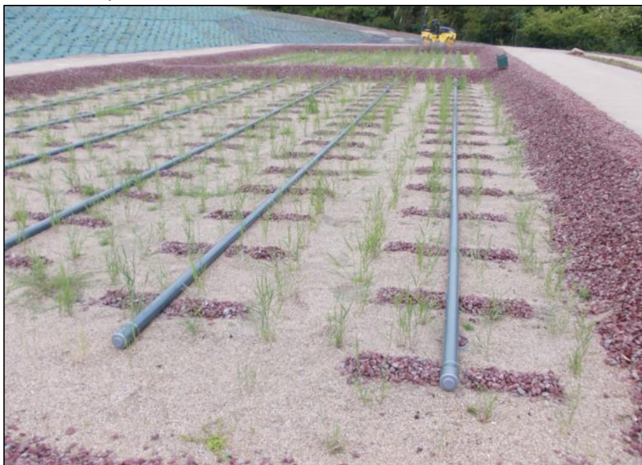
Photo 6 - Exemple de dispositif de répartition 2 ème étage
