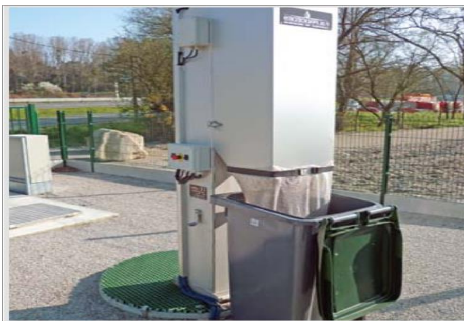
Figure 24 : Dégrilleur automatique
