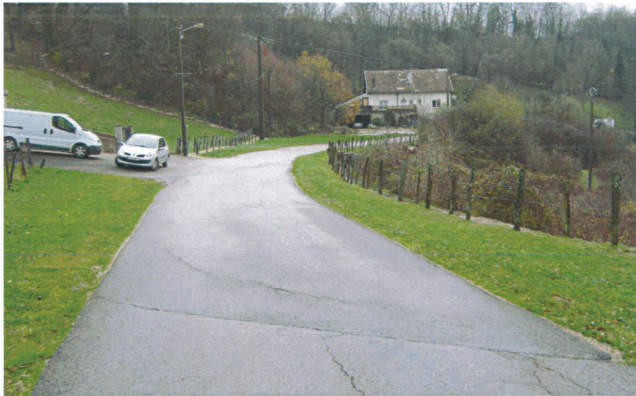
photo n°4 : rue Vallet, réparation de chaussée sur une zone de glissements avec présence d'eau ; au fond, le Trou au Loup.
