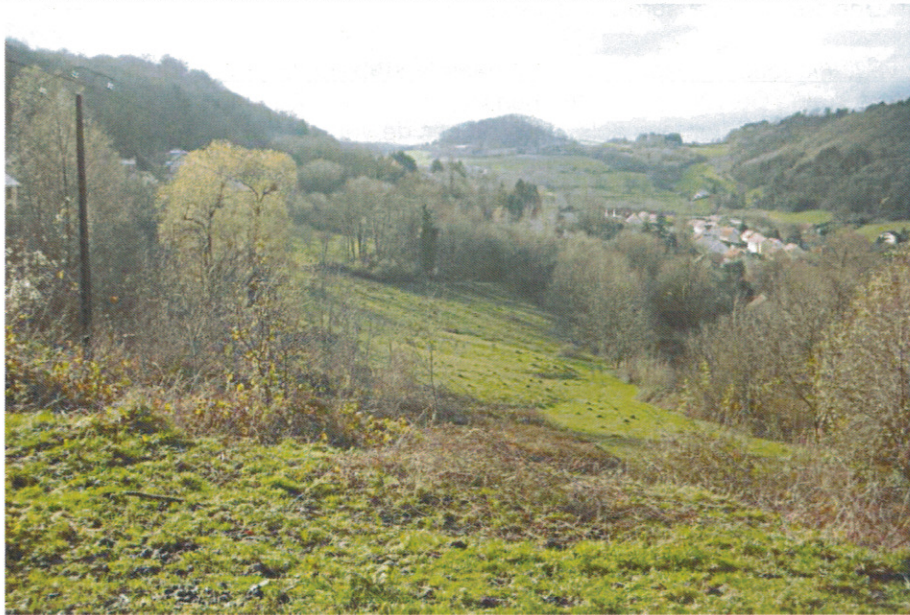
photo n°3 : glissement de talus dans les marnes en aval de la RN au niveau du Trou au Loup.
