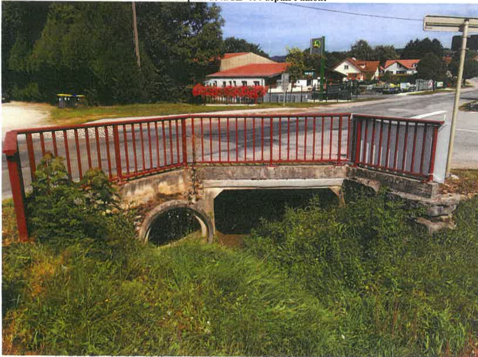
Vue du pont de la RD 464 depuis l'amont
