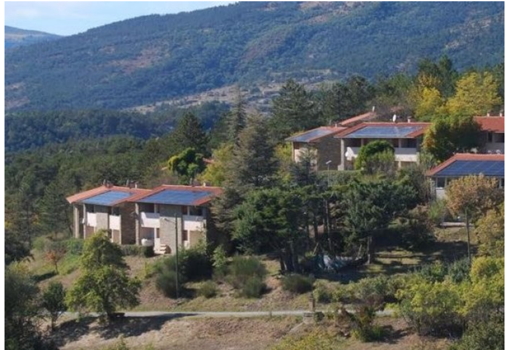
Centrale photovoltaïque villageoise à Rosans (Hautes-Alpes) : 8 bâtiments communaux pour la production annuelle de 74 045 kwh/an
