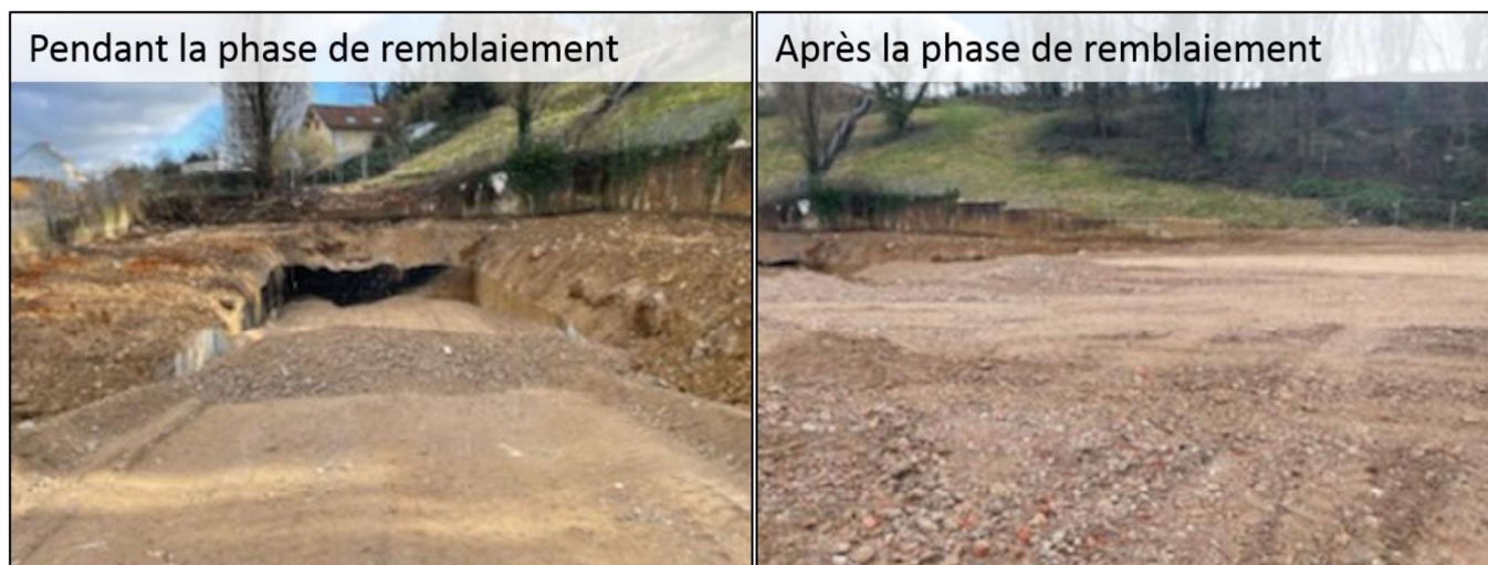
Figure 11 : Photographies pendant (à gauche) et après (à droite) la phase de remblaiement – Perl Environnement
