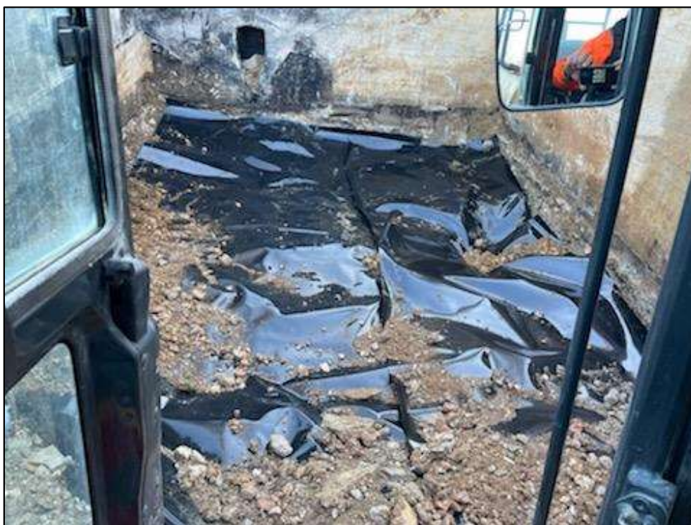
Figure 10 : Géomembrane mise en place sur les calcaires en fond de fouille – Perl Environnement
