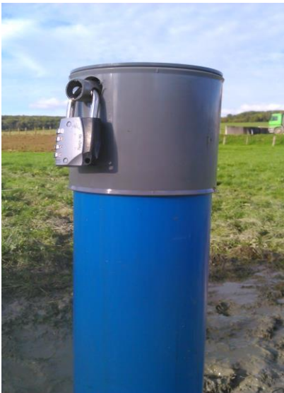
Figure 16 — Exemple de protection de la tête de forage (Source documentaire : BRGM)
