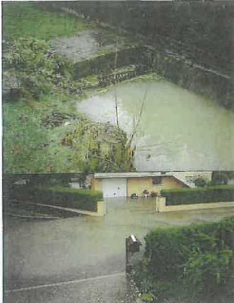
Collecteur saturé et inondation rue du stade
